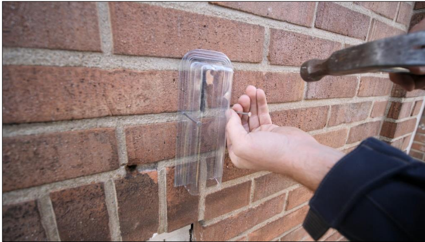
Voorbeeld van een exclusion flap: type EF1 exclusion flap (bron: Unitura.nl)
